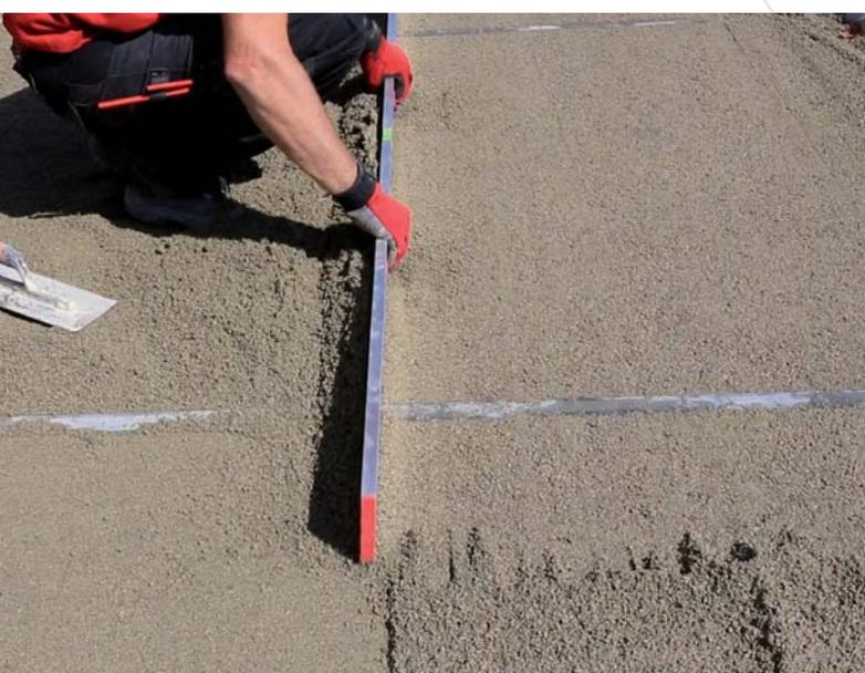
7 – Répartir et compacter la couche de pose de sable de rivière de 0/4. Cette couche peut être remplacée par du sable de 0/6,3 ou du gravillon de 2/4, 4/6,3 ou 2/6,3.
