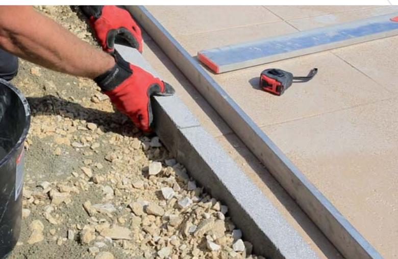
12 – Vérifier que le dallage a bien une pente de 2 %. Réaliser un drainage dans la partie basse de l'ouvrage. Poser une bordure sur la périphérie du dallage. Sur la partie basse, la bordure doit effleurer le dessus des dalles afin de laisser libre l'écoulement des eaux.
